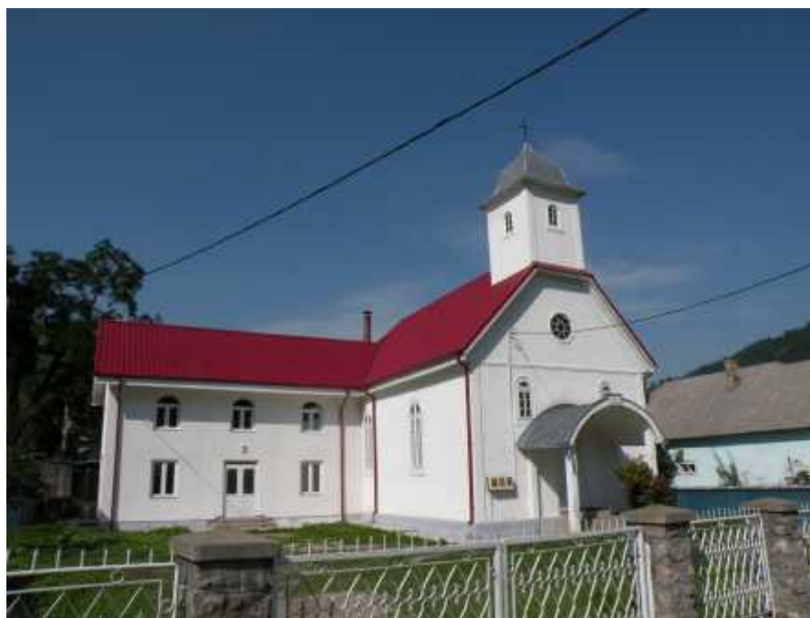
Img. 38 – Casa de rugaciuni baptista sat Bicazu Ardelean
