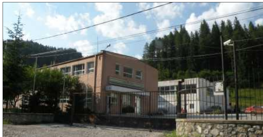
Img. 19 – Statia de imbuteliere ape minerale Tosorog
