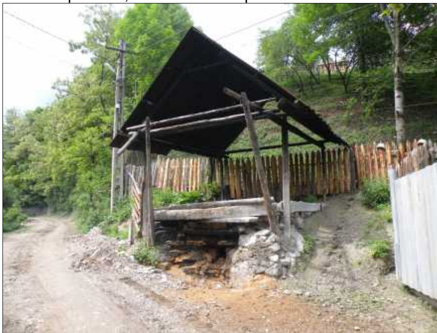
Img. 42 – Cuptor pentru obținerea varului nestins
